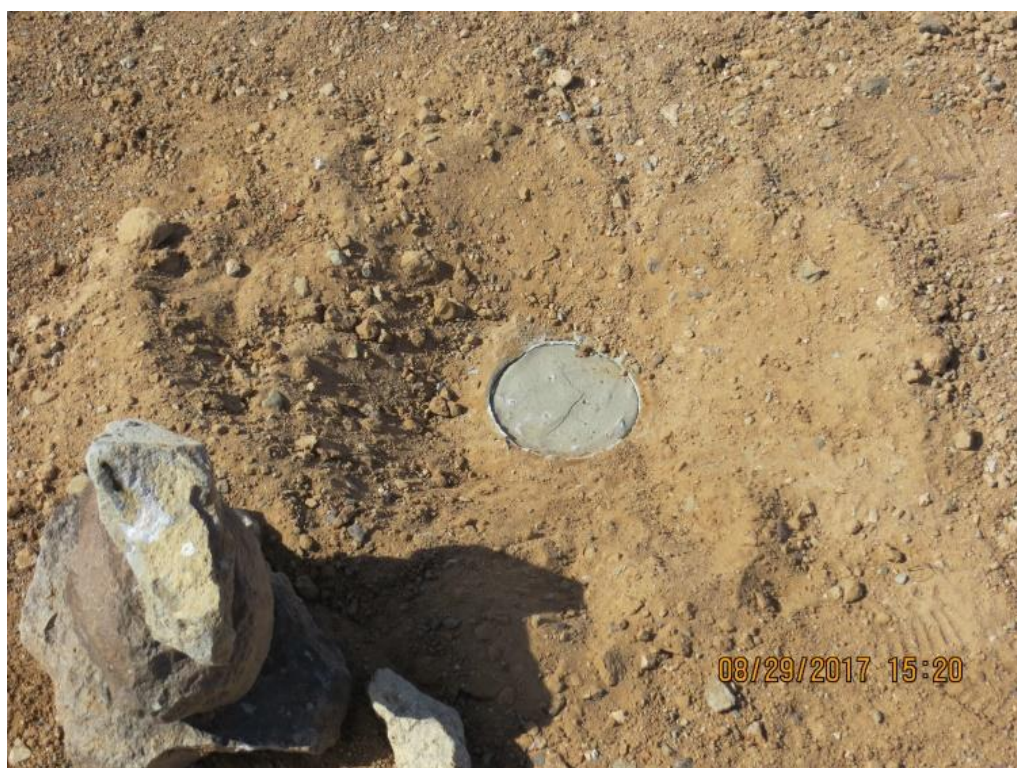
Зураг 40. Цооногийг битүүмжилсэн байдал
